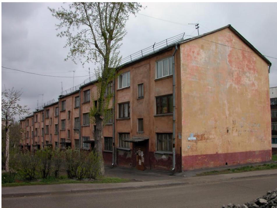
Рис. 37. Внешний облик жилого дома в квартале № 1, разработанный Эрнстом Маем. Входные курдоньеры, изображённые на плане жилого дома, были ликвидированы строителями как излишества в архитектуре
