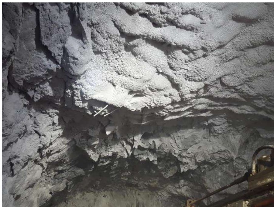
Рисунок 5.5. Участок кровли опытного участка ДШ-6 после производства взрывных работ (незакрепленная часть и закрепленная усиленной комбинированной крепью с торкретбетонным слоем)
