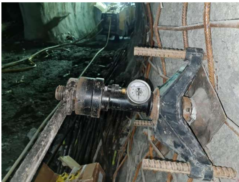
Рисунок 5.26. Испытания анкеров на несущую способность с использованием комплекта ПУШ для ПКА-1
