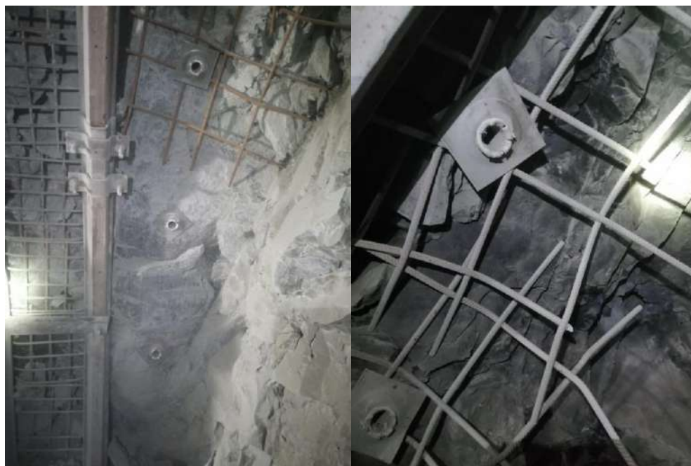
Рисунок 5.27. Установка анкеров на участке ШС-5
