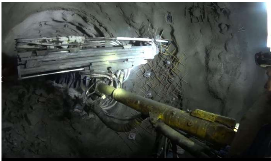
Рисунок 5.25. Крепление сбойки опытного участка
