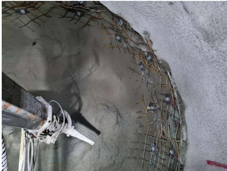
Рисунок 5.24. Участок выработки, закрепленный СЗА-Армокрепь поверх первого слоя торкретбетона (начало испытаний)
