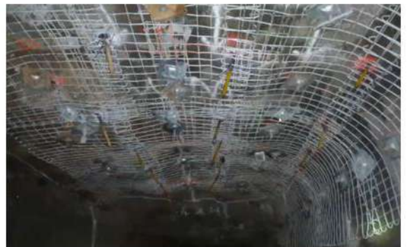
Рисунок 4.13. Вариант усиления крепи посредством анкеров глубоко (2-го порядка) заложения
