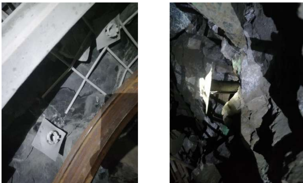
Рисунок 5.28. – Обыгрывание анкеров через 12 часов после установки
