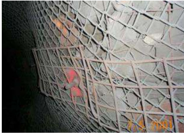
Рисунок 3.27. Система крепления пород, состоящая из армокаркасов, сеток и анкеров
