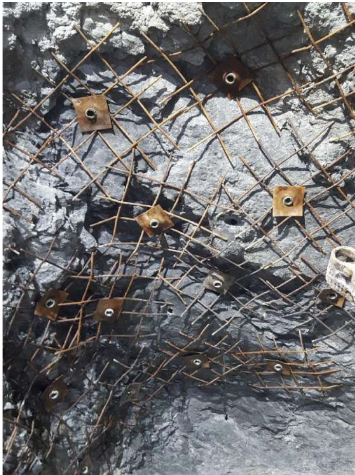
Рисунок 5.4. Фрагмент кровли выработки ДШ-6, закрепленный СЗА-Армокрепь
