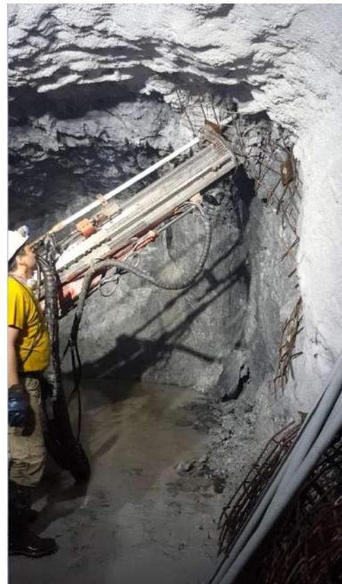
Рисунок 5.2. Стрела буровой кареты с демонтированными вкладышами люнет и установленным пуансоном (слева) и процесс установки СЗА-Армокрепь в сборе (справа)
