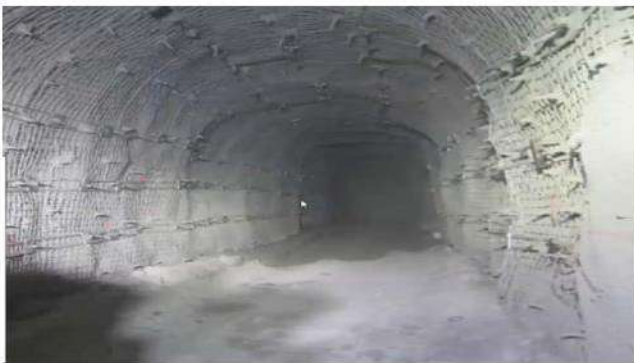
Рисунок 4.13. Вариант усиления крепи посредством анкеров глубоко (2-го порядка) заложения
