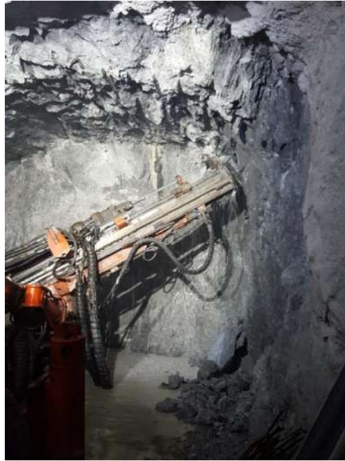
Рисунок 5.1. Процесс бурения шпуров под анкеры в забое опытного участка выработки ДШ-6
