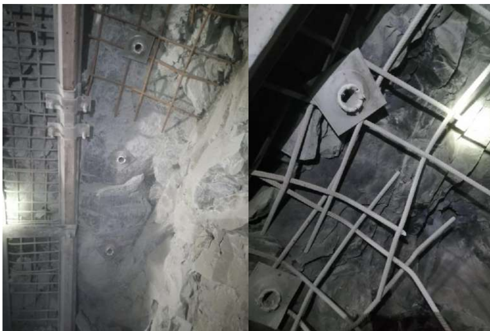
Рисунок 5.27. Установка анкеров на участке ШС-5
