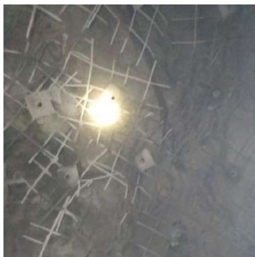
Рисунок 5.16. Фотография контуров горной выработки, закрепленных и покрывающим слоем набрызгбетона и анкерами СЗА с армокаркасами
