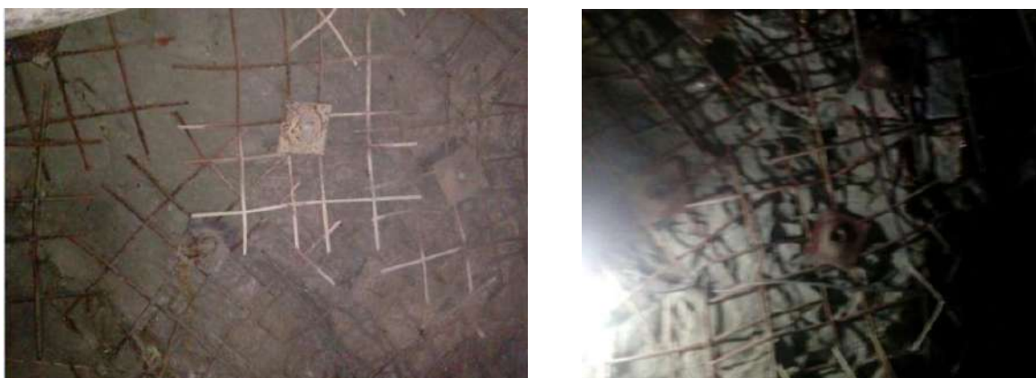
Рисунок 5.18. Участок горной выработки, закрепленный СЗА с армокаркасами без слоя набрызгбетона
