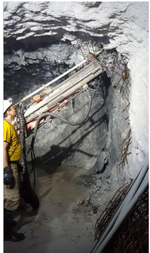
Рисунок 5.2. Стрела буровой кареты с демонтированными вкладышами люнет и установленным пуансоном (слева) и процесс установки СЗА-Армокреп в сборе (справа)
