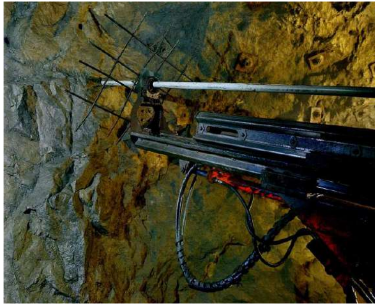
Рисунок 4.31. Пример установки СЗА-Армокреп с помощью самоходной буровой установки
