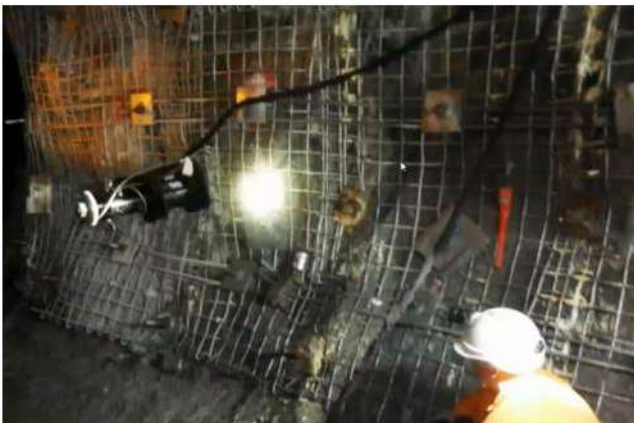
Рисунок 4.14. Комбинированные крепи с затяжкой периметра выработки сетками и армокаркасами
