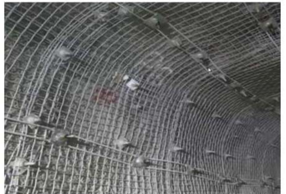
Рисунок 4.14. Комбинированные крепи с затяжкой периметра выработки сетками и армокаркасами
