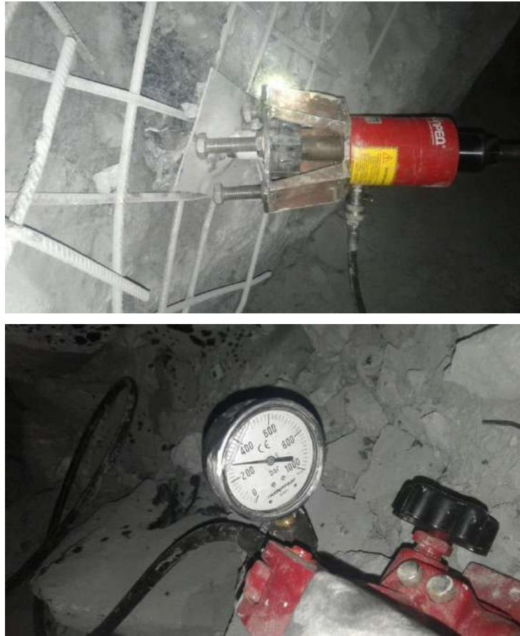
Рисунок 5.7. Испытания несущей способности анкерной крепи в ЗШ отм. +184 м
