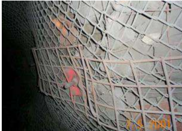
Рисунок 3.27. Система крепления пород, состоящая из армокаркасов, сеток и анкеров
