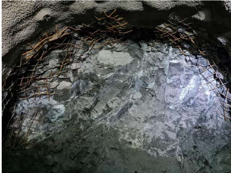
Рисунок 3.14. Фото характерного состояния массива в груди забоя выработки
