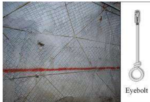
Рисунок 4.6. Тросовая шнуровка в глубокой выработке в ЮАР
