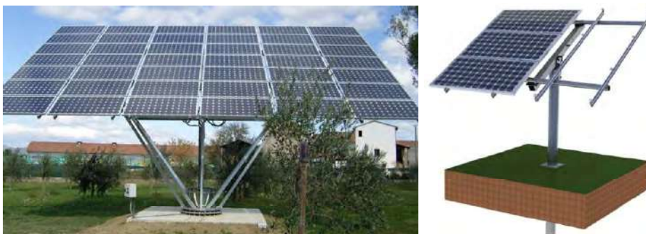
Рисунок 3.6 – Варианты установки солнечных панелей на опорно-поворотных мачтах
